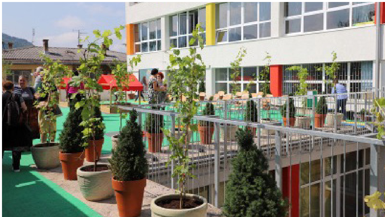
Slika 12: Zeleni krov na zgradi Osnovne škole "Hasan Kikić", Sarajevo (izvor: Općina Centar Sarajevo, 2023.)
